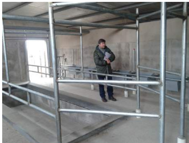
Sala de Ordeñe en ampliación y construcción nueva
